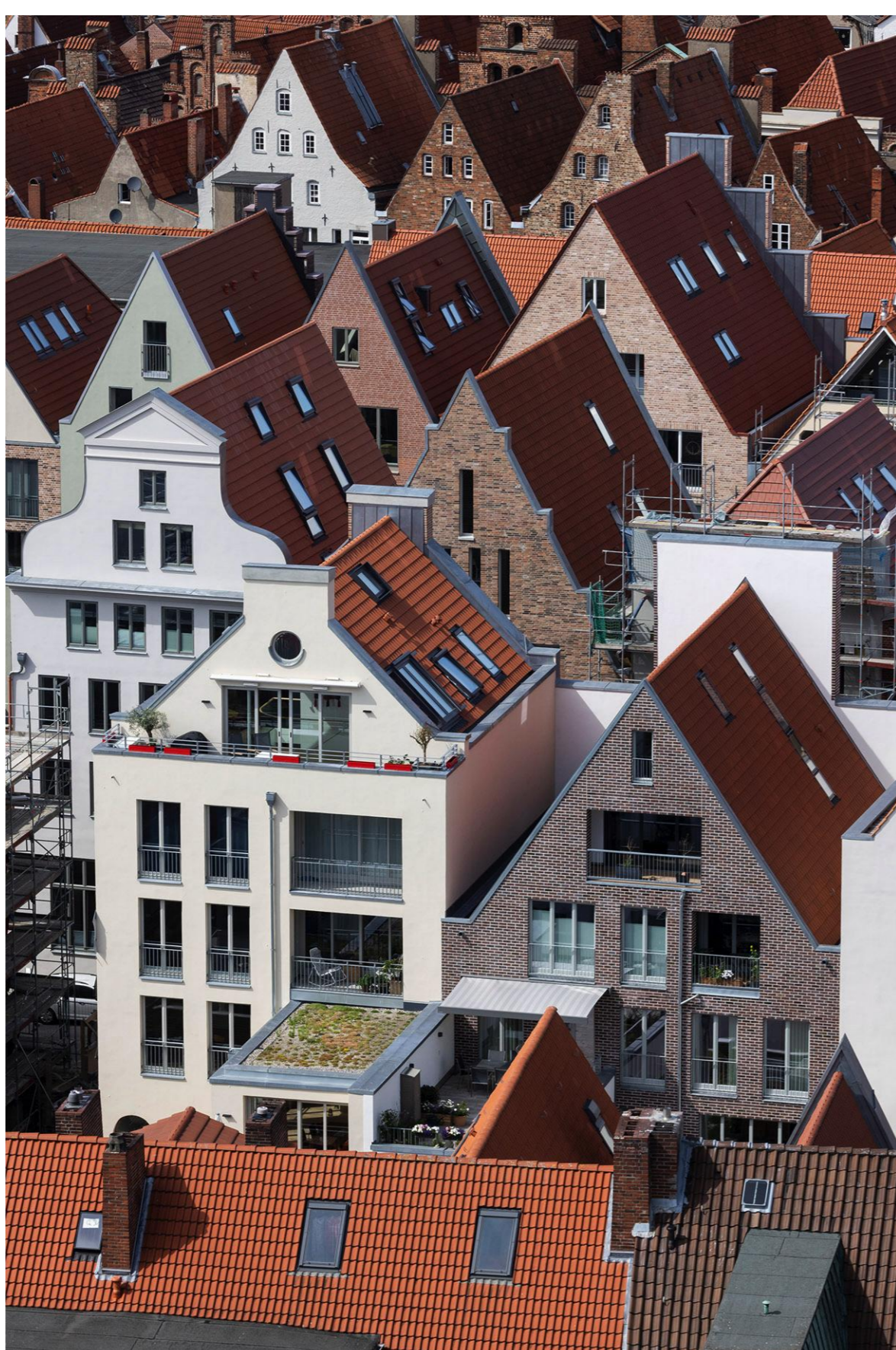
Ansicht Hofseite - Blick vom Turm der Petrikirche
