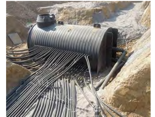
Erdwärmesonden Sammelement außen Ansicht © Stadtwerken Warendorf
